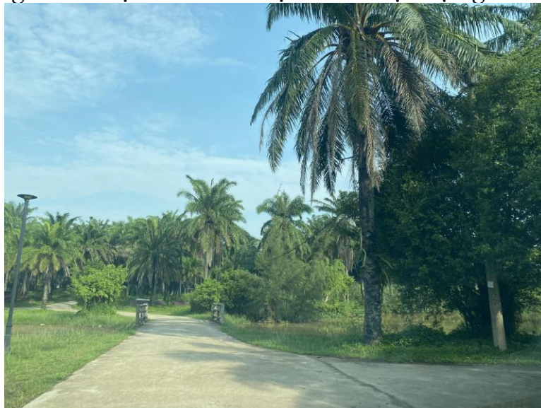
Công viên du lịch sinh thái Cọ Dầu – cầu bê tông
