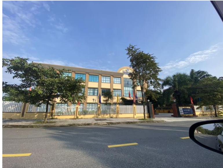
Trụ sở Truyền tải điện
